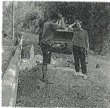
Lavori in corso su una strada devastata dall'alluvione
