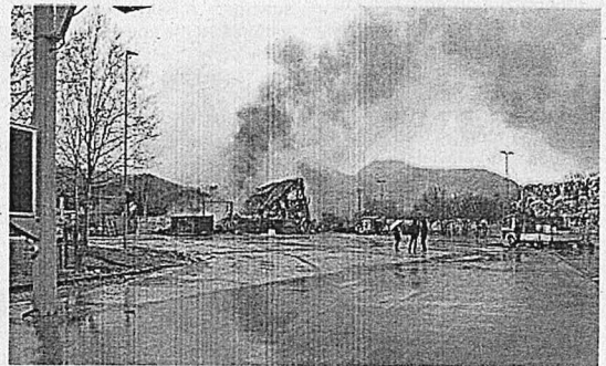
La colonna di fumo sopra i resti dell'impianto distrutto. I tecnici di Arpae hanno effettuato rilevazioni che escludono allarmi ambientali
