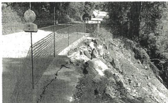
I lavori sulla provinciale Cesena-Sorrioli di Roncofreddo
